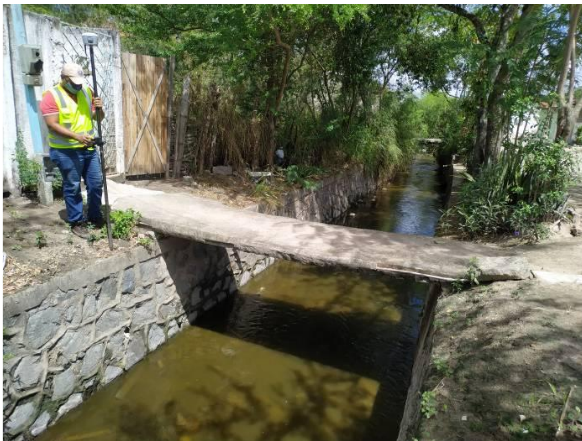
Figura 4 - Caracterização do canal no trecho revestido
