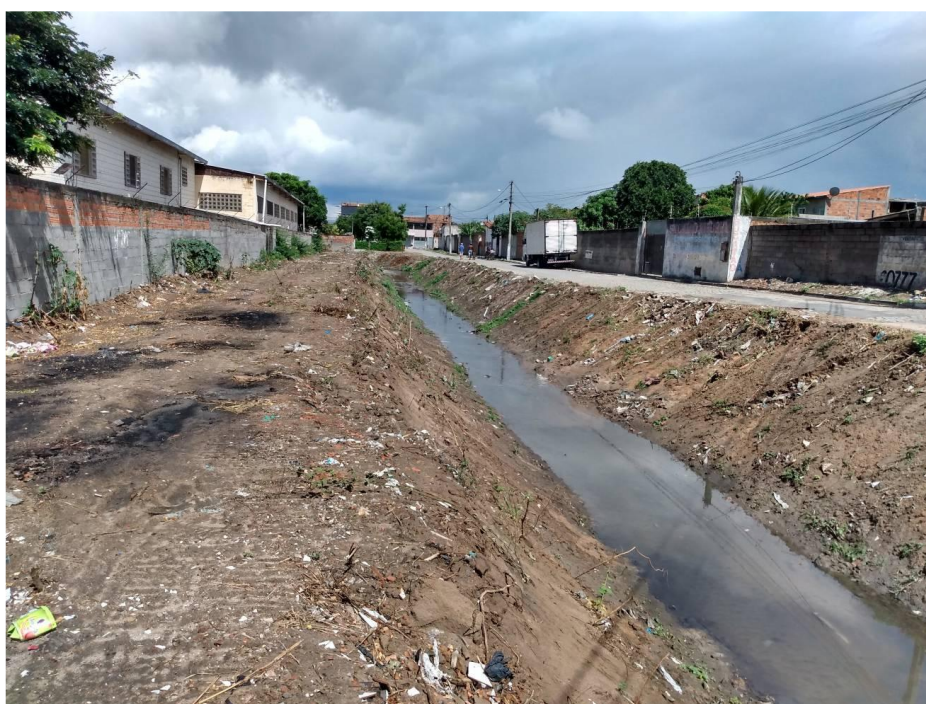
Figura 10 - Caracterização do canal no trecho não revestido
