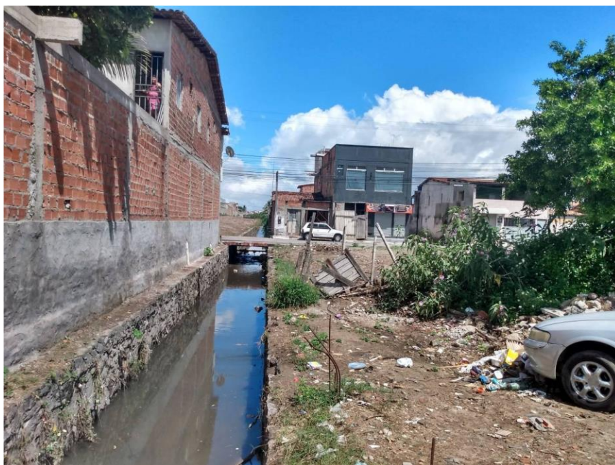
Figura 9 - Caracterização do canal no trecho revestido
