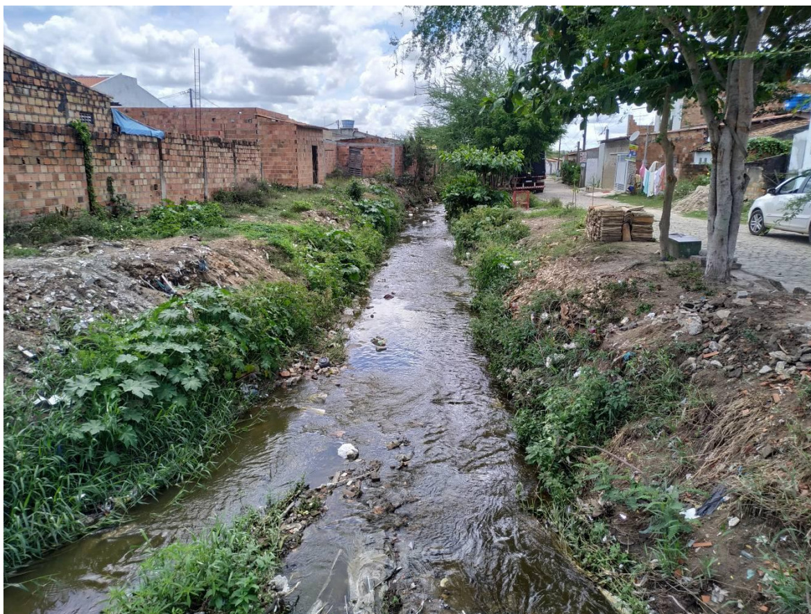
Figura 5 - Caracterização do canal no trecho não revestido
