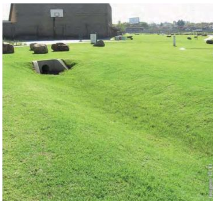
Figura 79 - Exemplo de vala em Soweto, África do Sul
